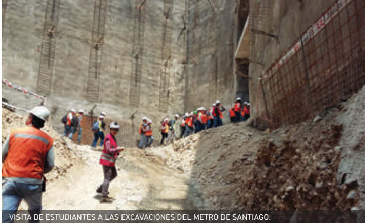
VISITA DE ESTUDIANTES A LAS EXCAVACIONES DEL METRO DE SANTIAGO.
