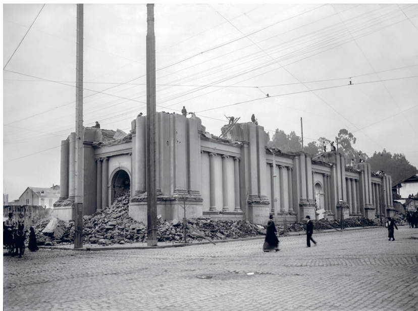
Figura 3: Demolición del monasterio de las monjas clarisas, Santiago, 1913.
