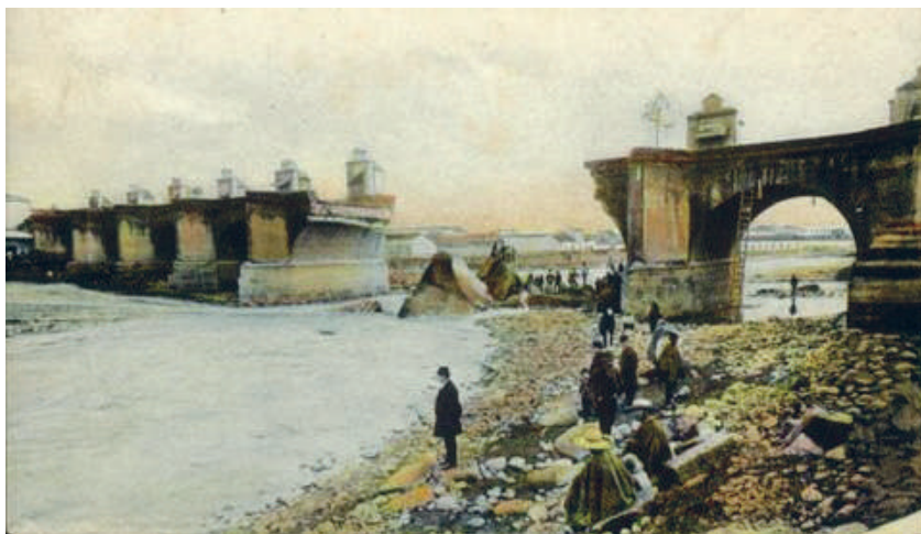
Figura 2: Demolición del Puente Cal y Canto, Santiago, 1888.
