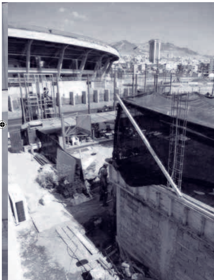
Trabajos de modernización de infraestructura en sede Antofagasta.
